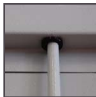
пластмассовая втулка ригельной системы
