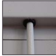
пластмассовая втулка ригельной системы
